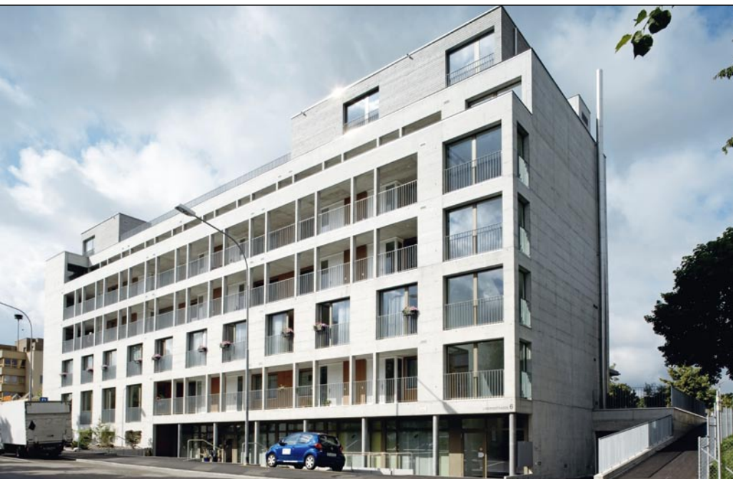
Der Neubau von der Strassenseite. Laubengänge erschliessen die Wohnungen.
