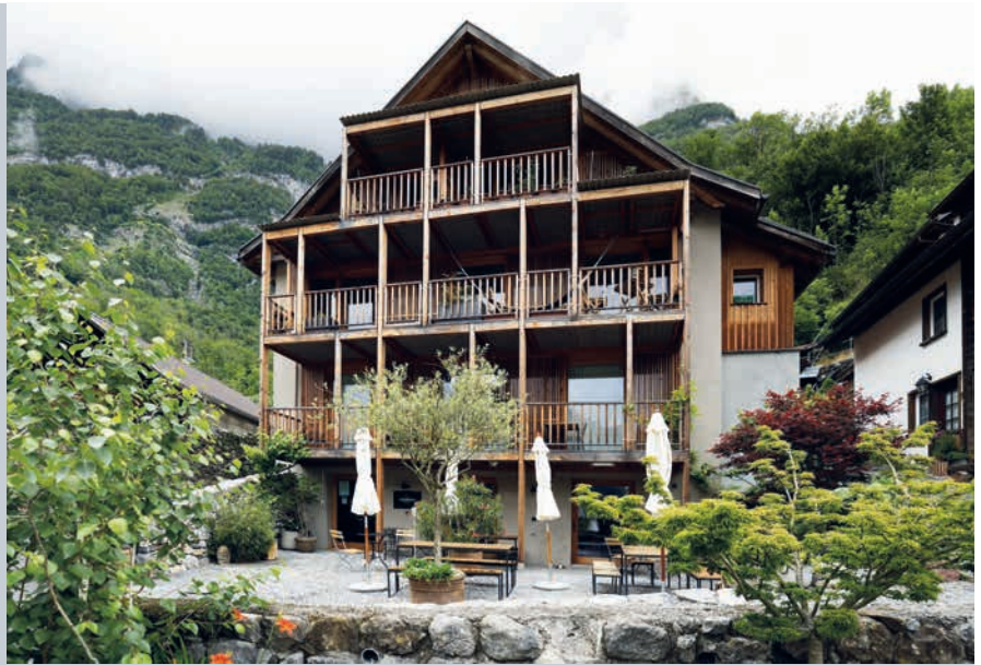
Die ehemalige Bauruine bietet Raum für Wohnen und Gewerbe.
