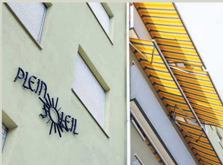
Das Gebäude erstrahlt in neuem Glanz.
