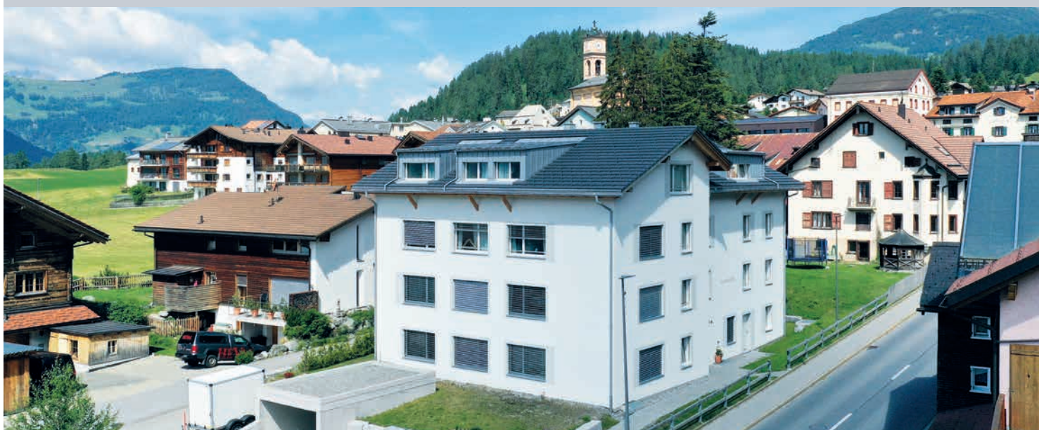
Der Neubau im Zentrum von Lantsch/Lenz fügt sich gut ins Ortsbild ein.
